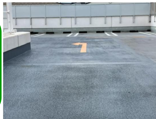
<ウレタン防水下地改修 施工完了>
