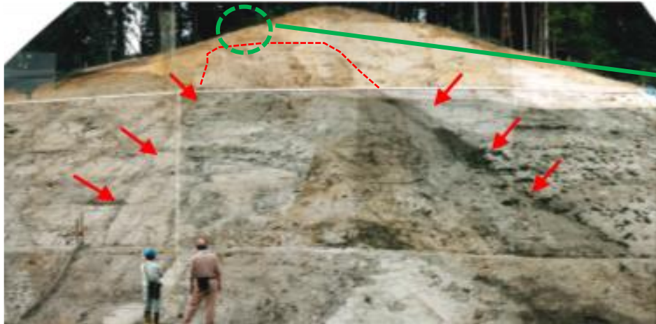
a) 崩壊前の割れ目状況
