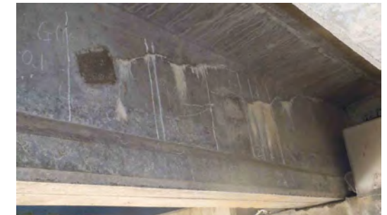
ひび割れパターン⑳ シースに沿って生じるひび割れ
