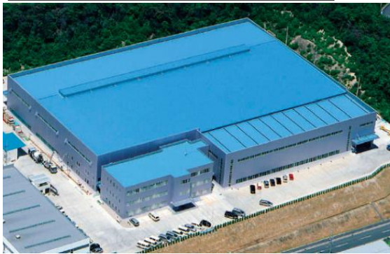
③屋根・壁(日鉄鋼板SGL製)
