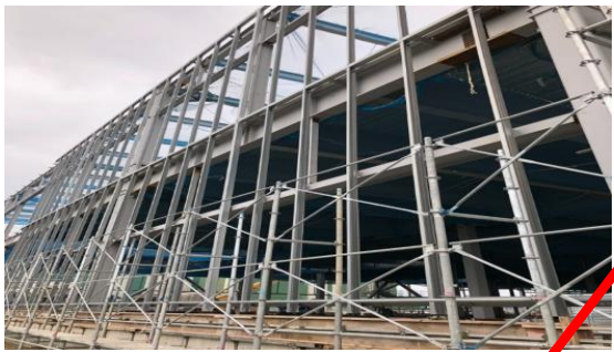
③屋根・壁(日鉄鋼板SGL製)
