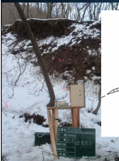
地盤伸縮計設置状況
