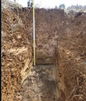
最大高さ2.5mのトレンチを掘削。 トレンチ底面に見える黒い部分が旧地盤面。褐色の部分が移動土塊。
