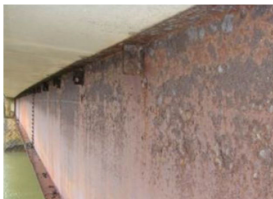
主桁の腐食
