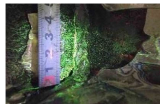
磁粉探傷試験結果（亀裂あり）
