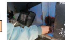
超音波探傷試験状況
