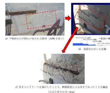
図 1-1 鉄筋腐食による表面被覆材の割れ
