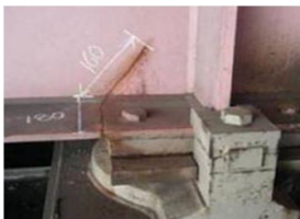
主桁の亀裂
