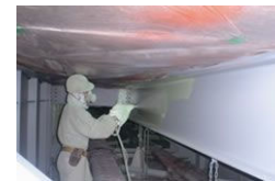
塗替え塗装（スプレー）状況
