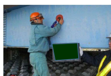
調査状況（全景）
