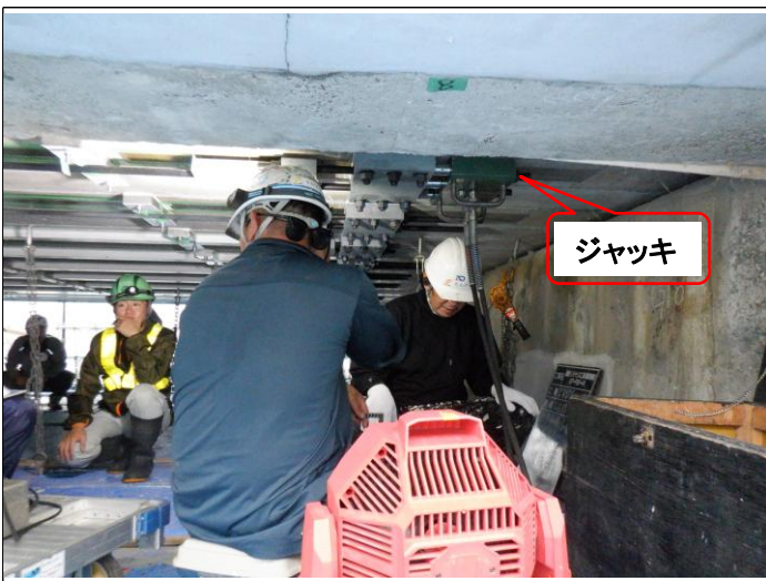
名 称 : OP工法 緊張作業 ジャッキ側
