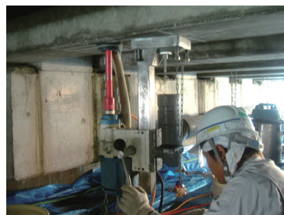
② 定着アンカー削孔
