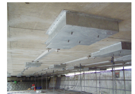
⑧ 定着装置防錆処理
