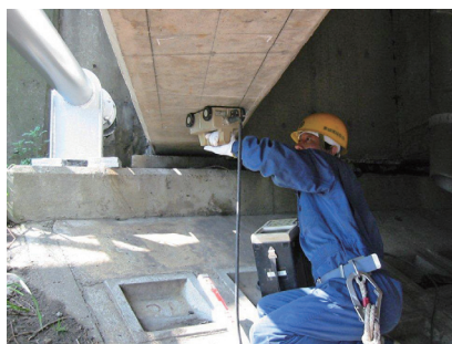
① 鉄筋探査
