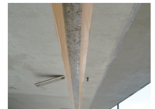
④ 接着面プライマー塗布
